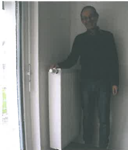
Im Neubau: Der Installationsort ist dank Mittenanschluss nicht mehr von der Länge des Heizkörpers abhängig – ein Vorteil auch für den Fachplaner Josef Spielmann. (Foto: HeizungsJournal)
