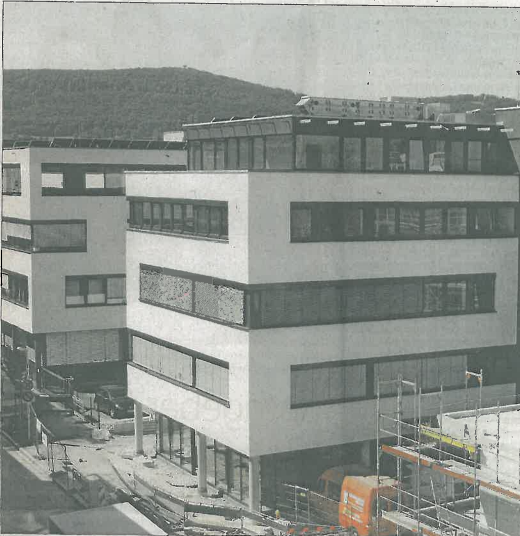
Das Facharztzentrum II: Seine Fassade ist dem bereits seit vier Jahren bestehenden Facharztzentrum I im Hintergrund nachempfunden. Rechts die aktuelle Baustelle der Essinger Wohnungsbau auf dem ehemaligen Simon-Gelände. (Fotos: Eva Gaida)
