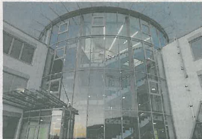
Bürogebäude in Aalen.
