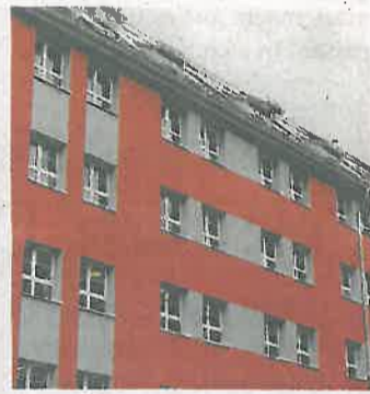
Neu eingezogene Fensterbänder.
