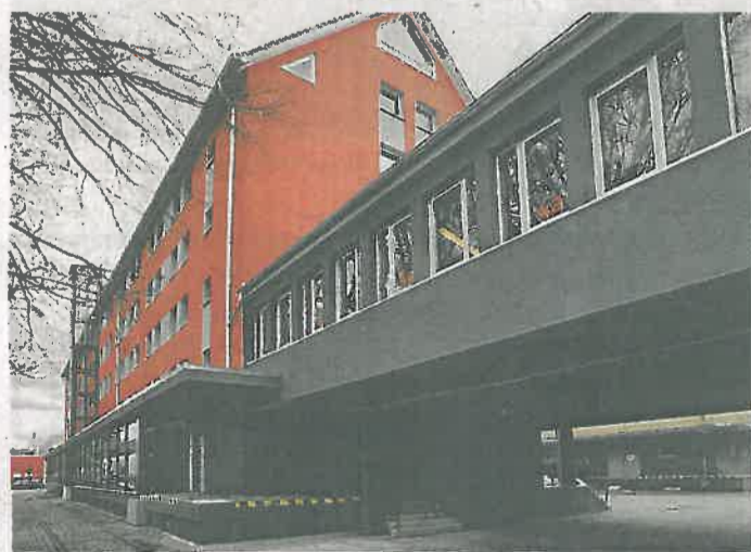
Modern wurden Verbindungsbrücke zwischen den Häusern Nummer 80 und 68 sowie Schaufenster auf den ehemaligen Rampen gestaltet.
