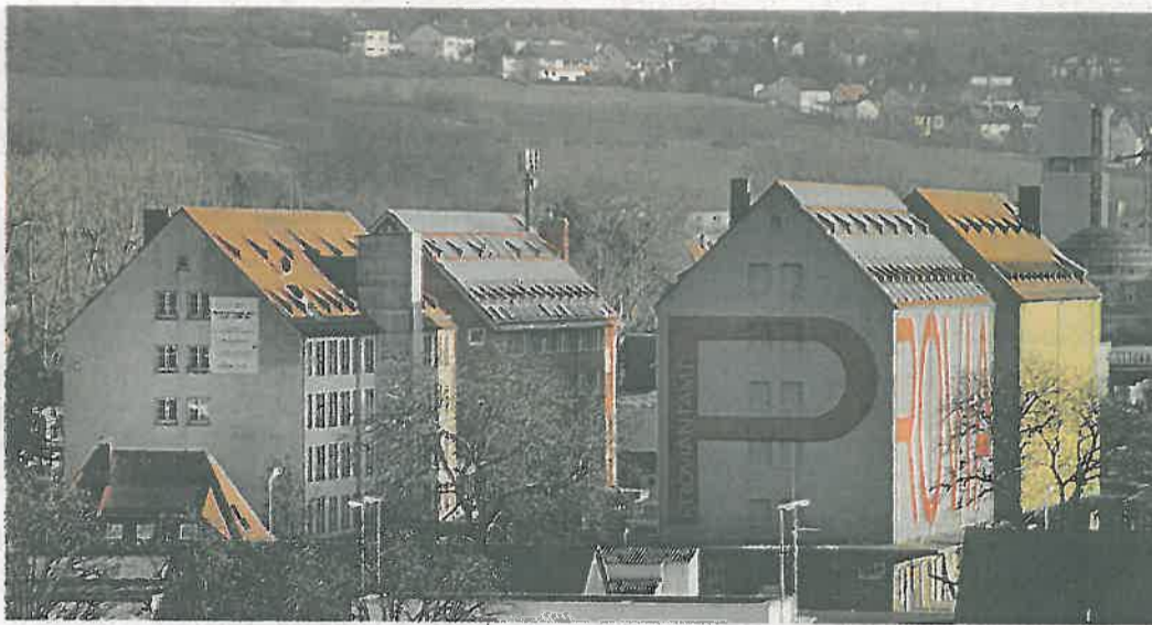
Das Ensemble des Proviantamts wurde grundlegend ertüchtigt.
