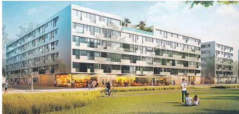
Das Heidelberger i Live-Projekt zählt zu den größten konzipierten Passivhaus-Objekten europaweit.
