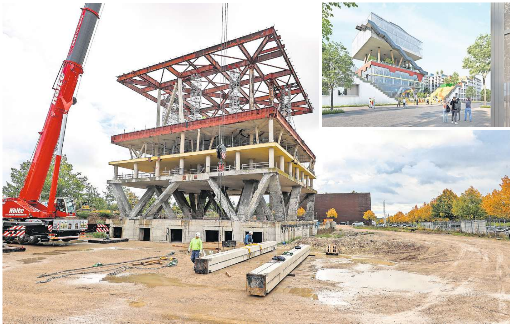
Abbau: Vom ehemaligen Holländischen Pavillon steht nur noch das Stahlgerüst der unteren Etagen. Aktuell werden die 200 Jahre alten Eichenstämme entfernt und durch Betonpfeiler ersetzt. Das kleine Bild zeigt, wie alles einmal aussehen soll, wenn es fertig ist – mit einer Außentreppe und viel Glas.
