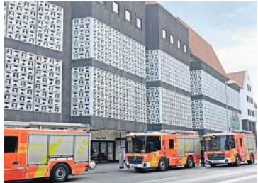
Einsatz für die Feuerwehr: 60 Kubikmeter Wasser liefen aus.
